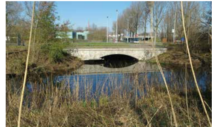
Brug 1863 gezien vanuit de Oeverlanden | Foto: Nico Jansen
