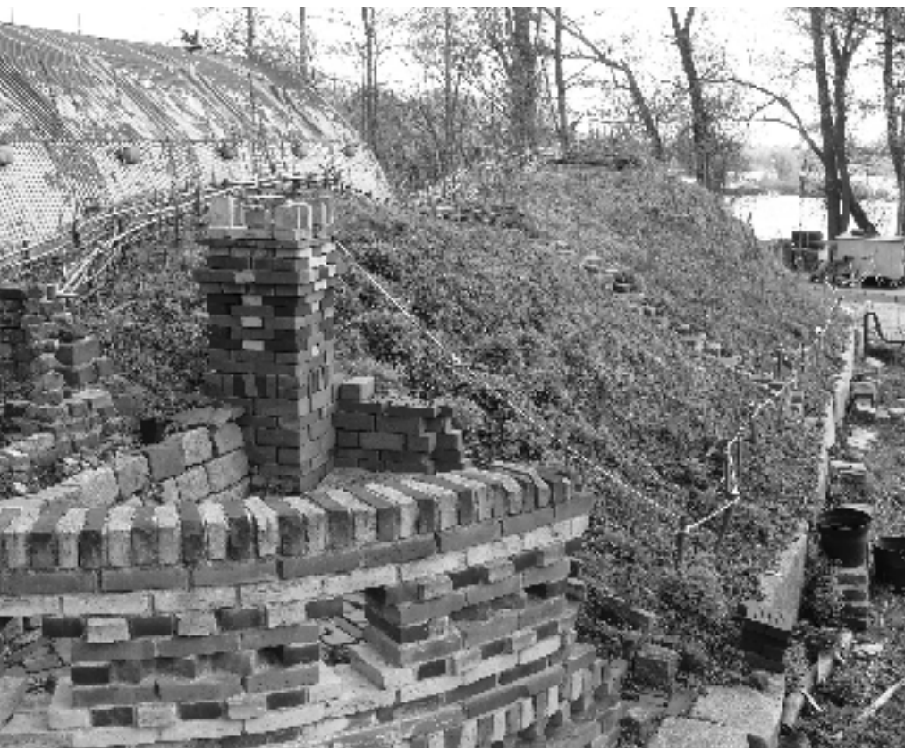
De vleermuisbunker vanaf de achterzijde gezien, naast de grote loods. Op de voorgrond een met ouderwets kalkmortel gemetselde vegetatiemuur. foto: Hans Bootsma
