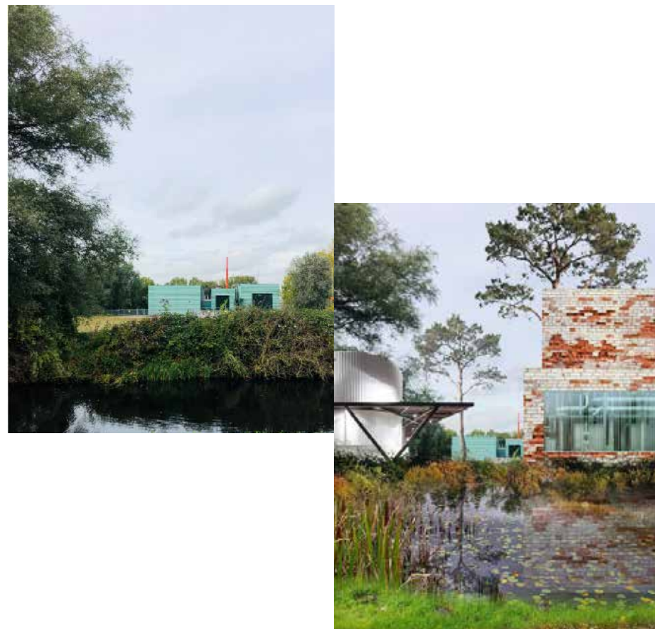
Onderstation aan de Anderlechtlaan, Gemeente Amsterdam, 2020
