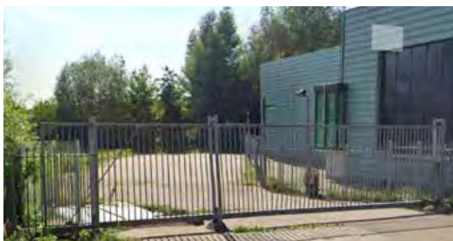
Bestaande poort (hoofdontsluiting)
